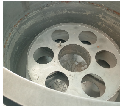
Vidéo : monitoring sur la cuve avec défaut.
