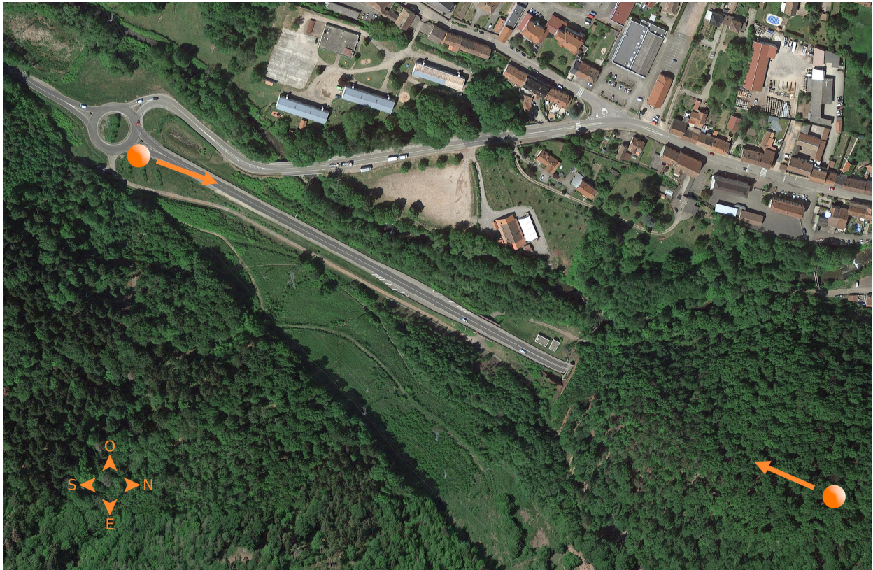
Figure 3 – Implantation des caméras à l'extérieur et à l'intérieur du tunnel de Schirmeck
